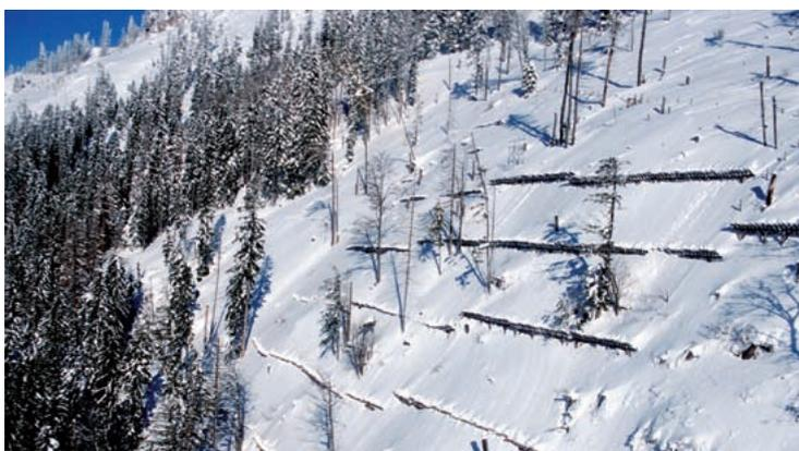
Ouvrages para-avalanches au Bläserberg (SG): Lorsque la forêt protectrice manque, des ouvrages techniques très onéreux doivent la remplacer. (Photo: R. Schwitter)
