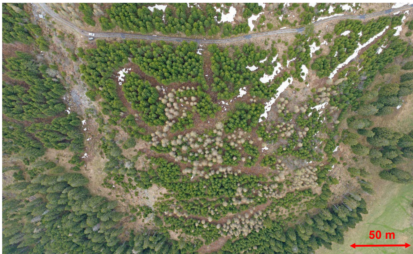
La compartimentation de Dürabodawald après l'intervention (vol de drone Ch. Rüsch, juin 2022).
