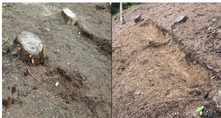
Abbildung 2: Manuell erstellte Tellerbermen (l.) und Kleinterrasse (r.) in Scharinas, Tujetsch (GR). Die Wahl geeigneter Kleinstandorte ist für den Erfolg entscheidend (z.B. Gleitschneeschutz durch Stümpfe). Fotos: A. Carella (l.), A. Deragisch (r.)
