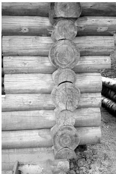
Abb. 2: 100 Weisstannen nach kanadischem Vorbild verbaut. Eckverbindung eines Blockhauses, Hirschthal AG
