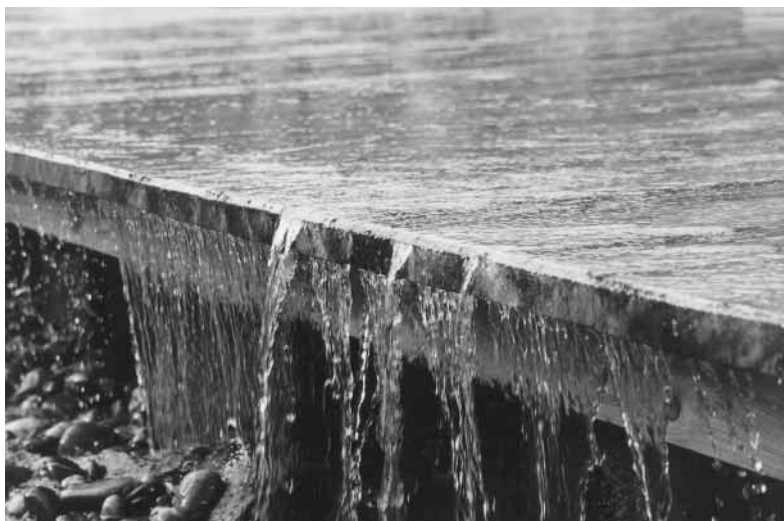
Abb. 3: Dank guter Dauerhaftigkeit eignet sich die Tanne für den Wasserbau. Schwellenmätteli, Bern
