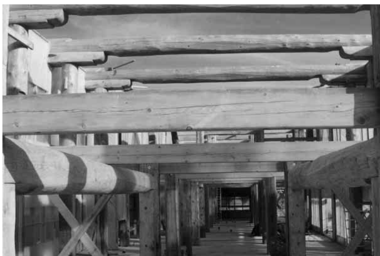
Abb. 6: Eine wirtschaftliche Lösung mit Tannenholz: Stützen und Träger auf einfachste Art und Weise gefertigt (hier im Rohbau), Karateschule Kenseikan, Allmendingen
