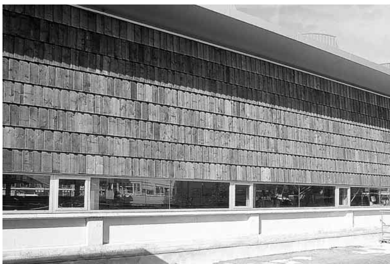
Abb. 4: Moderne Interpretation einer Schindelfassade mit 16000 Tannenbrettchen (30x75x3 cm). Werkstattgebäude der SBB, Genf
